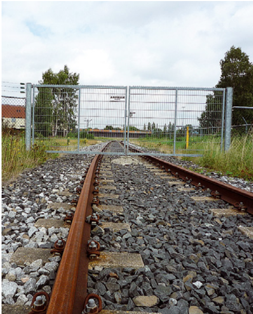
Figuur 5. Toegang naar spoorwegemplacement bij Arnhem. Het ballastbed is biotoop waar de kiezel-sprinkhaan is aangetroffen. Foto Jaap Bouwman. Figure 5. Entrance to railway complex near Arnhem. Sphingonotus caeruleans was found on the shingle bed. Photo Jaap Bouwman.
