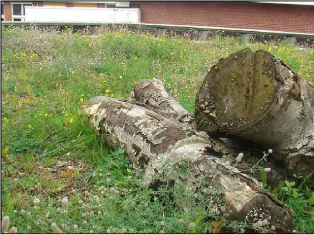
Figuur 2. Vegetatiedak in Groningen-centrum. Boomstronken voorzien het dak van structuur; bijen vinden er nestelgelegenheid en luwte.
